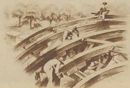
Bild rechts: Die Zimmerleute bei der Arbeit am Lehrgerüst
