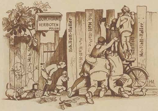
Der Bau der Kornhausbrücke erfreut sich des lebhaften Interesses der gesamten Bevölkerung
